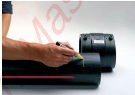
Рис.16 Нанесение отметки после очистки
