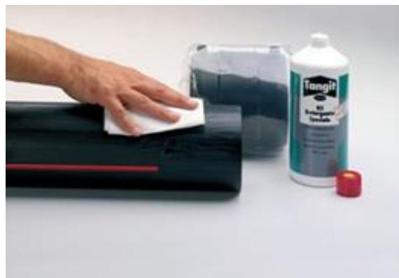
Рис.11 Обезжиравание трубы
